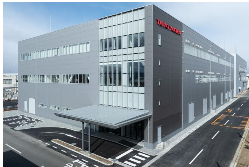
玉村工場5号棟
