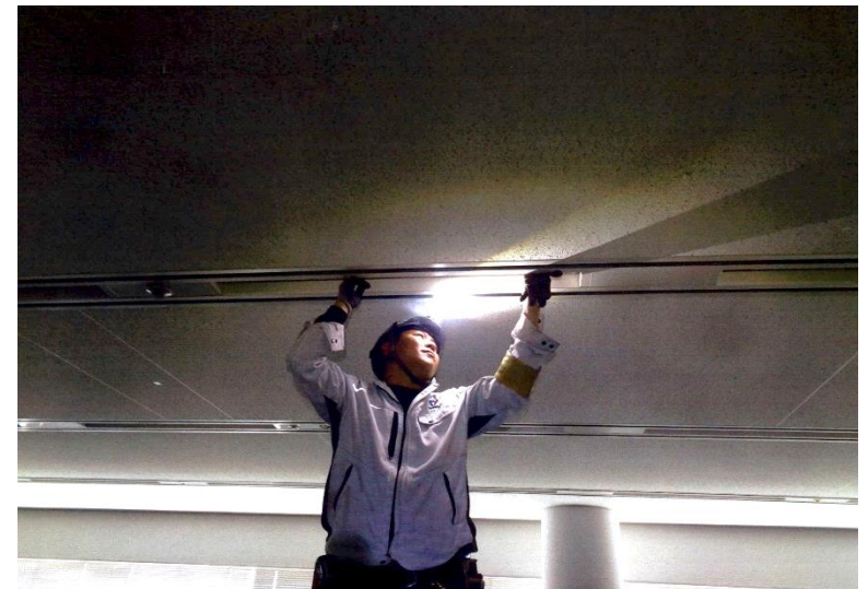
照明LED化工事
