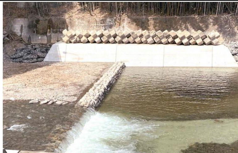
【河川防災工事（県発注）】
