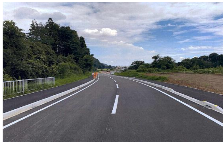
【道路新設工事（市発注）】
