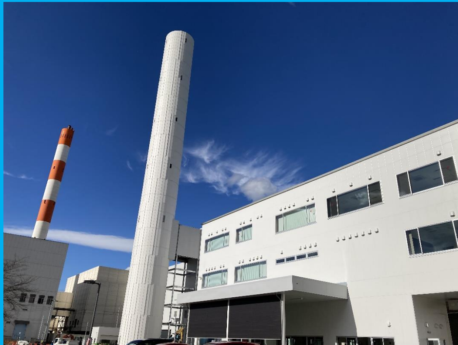
↑ 左 旧高浜クリーンセンター 右 新高浜クリーンセンター
