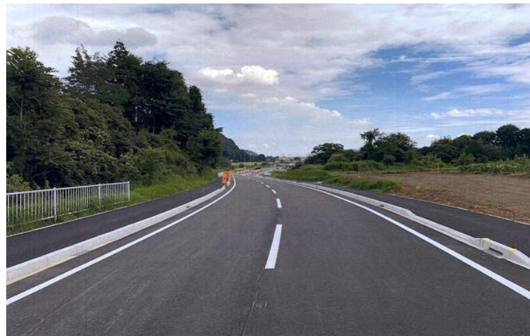
【道路新設工事（市発注）】
