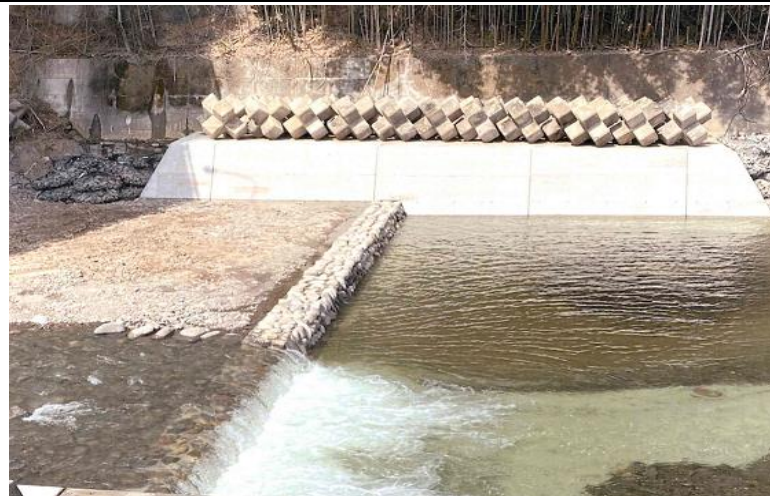
【河川防災工事（県発注）】
