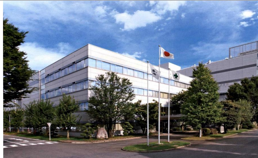
本社・半導体事業部の工場棟。群馬県高崎市を主要拠点に、世界を相手とした事業展開をしています。
