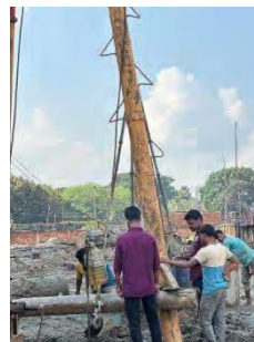
【バングラデシュの工事現場】
