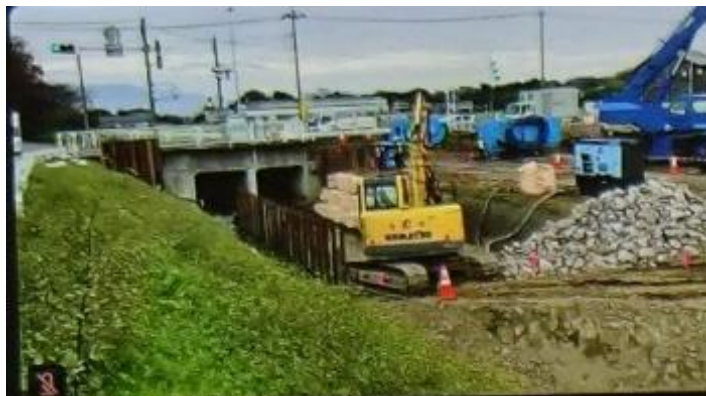
【当日の現場作業の様子】
