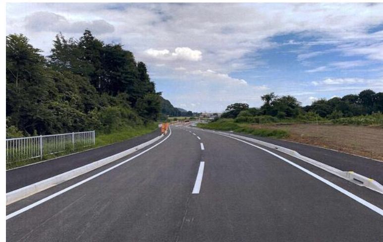
【道路新設工事（市発注）】
