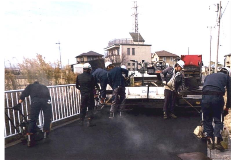
レーキ、プレートによるアスファルト敷き均し転圧作業
