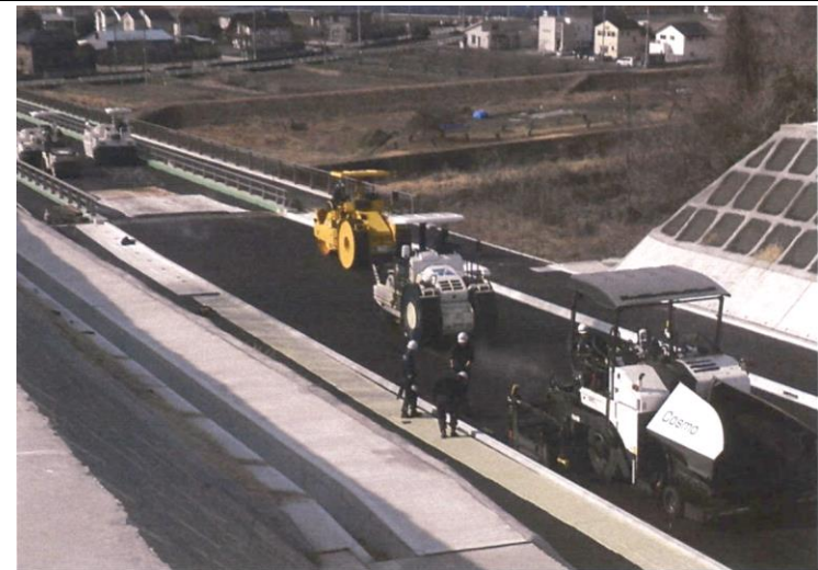
アスファルトフィニッシャー、マカダム、タイヤローラーによる舗設作業状況
