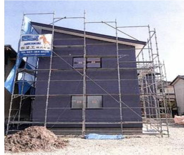
建築中の弊社モデルハウス兼事務所です。(2023年完成予定)
