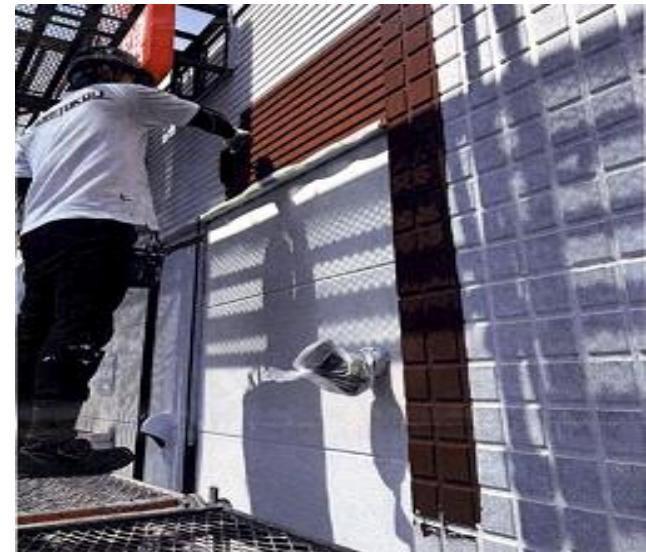
作業中の様子です。
