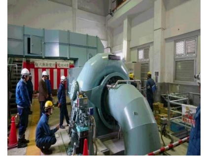
作業風景（試験）
