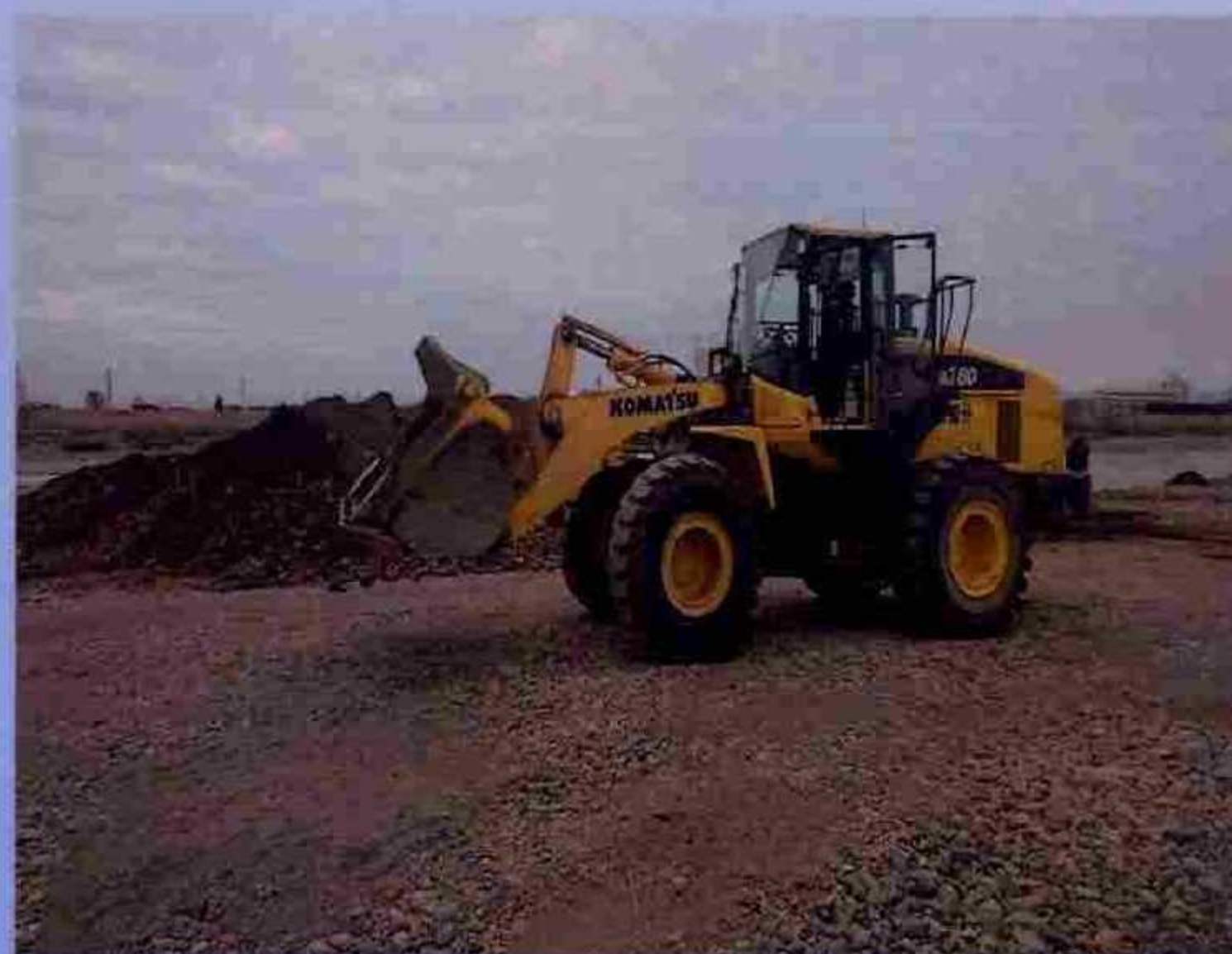
河川での作業状況
