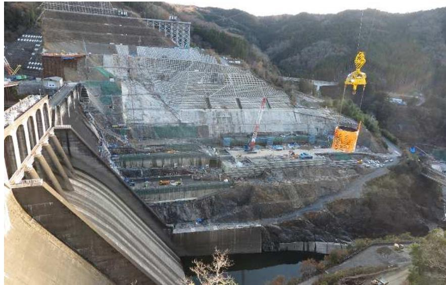
新丸山ダム本体建設工事現場ではDX(デジタルトランスフォーメーション)を活用し、ダム建設における「自律型コンクリート打設システム」(コンクリート運搬に使用するケーブルクレーンの自動・自律運転)を成功させるなど、工事の品質を保ち、省人化や、生産性、安全性の向上を目指しています。
