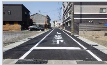
令和4年度 道路側溝改良工事
