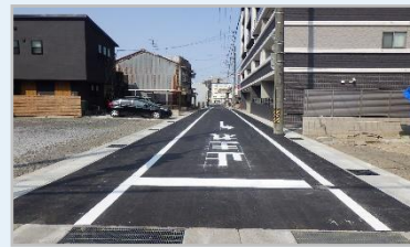
令和4年度 道路側溝改良工事
