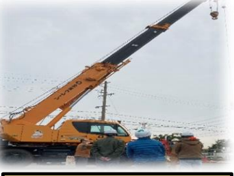
② 16t クレーン
