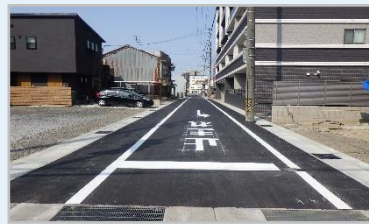
令和4年度 道路側溝改良工事
