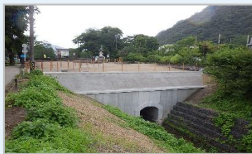
令和3年度 岐阜公園せせらぎ緑道整備工事
