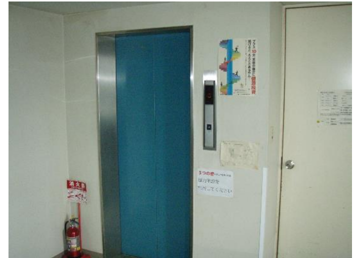
エレベーターの利用制限 (上下近接階の階段利用)
