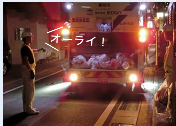
後方の状況を確認しながら作業者が発声する
