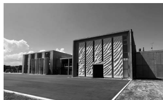
福島RDMセンター研究開発棟
