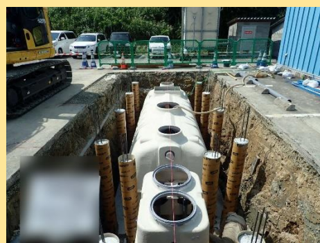
【浄化槽工事メンテナンス】
