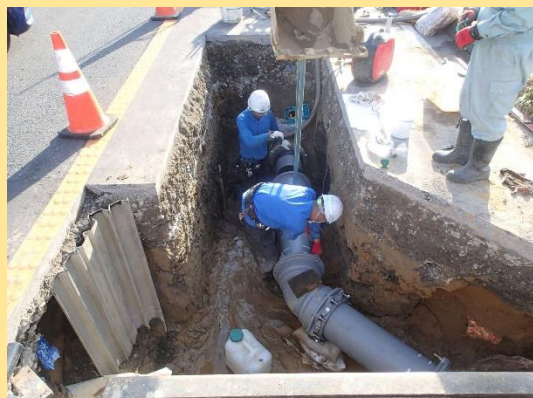
【ライフライン公共工事】
