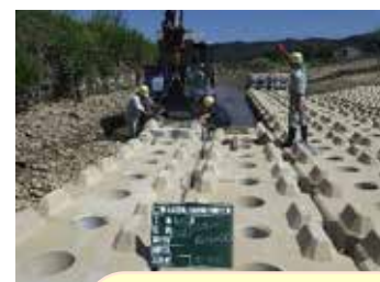
【洗掘防止】 根固めブロック据付作業
