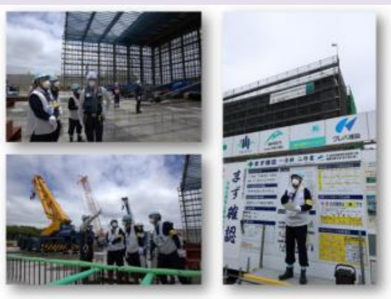
廃炉作業現場における安全パトロール
