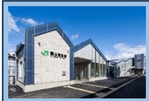
郡山富田駅新設
