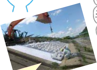
災害工事で大型ブロック張 をしています!
