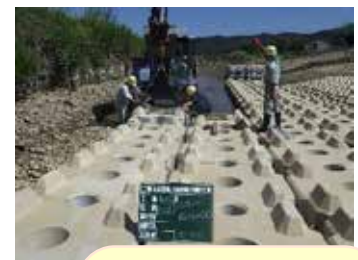
【洗掘防止】 根固めブロック据付作業
