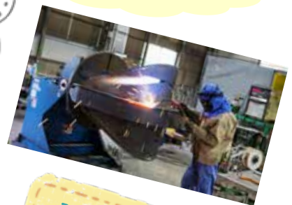
溶接作業をしている風景
