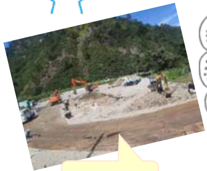
現場作業の様子
