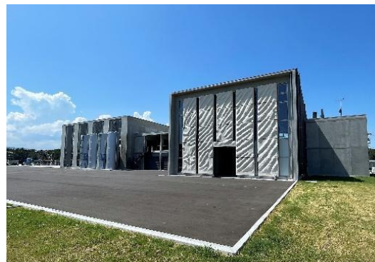
福島RDMセンター研究開発棟
