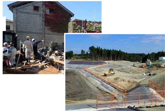
【解体作業現場・中間貯蔵施設での監督指導】
