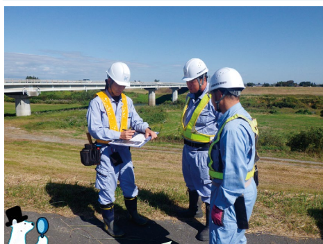
作業前の打合せ風景
