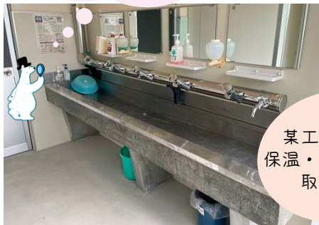
給食センター手洗い場保温 ステンレス板金取付工事
