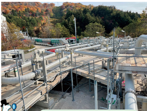
某工場蒸気配管保温・カラー板金取付工事
