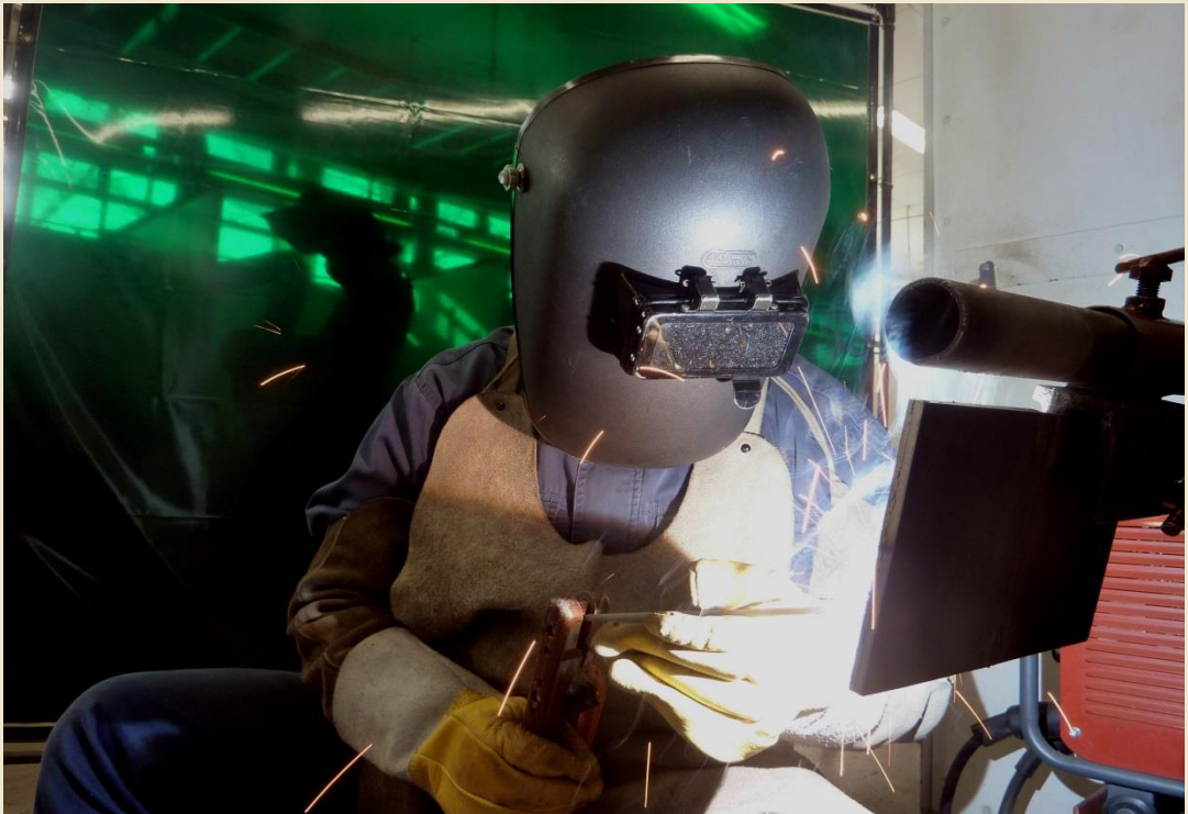
・被覆アーク溶接
