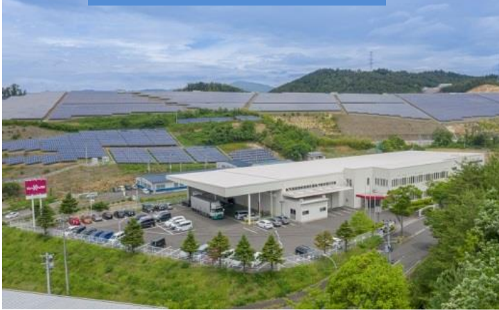
会社全景(福島工業団地内)
