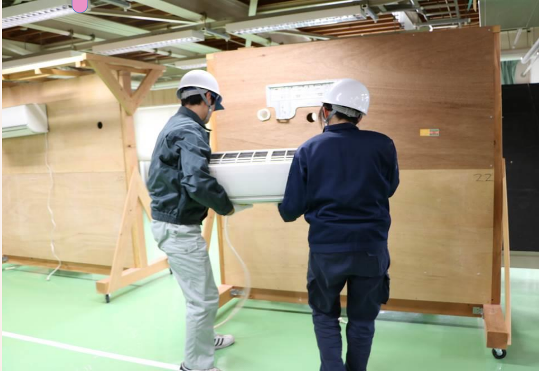
・空冷式エアコンの工事
