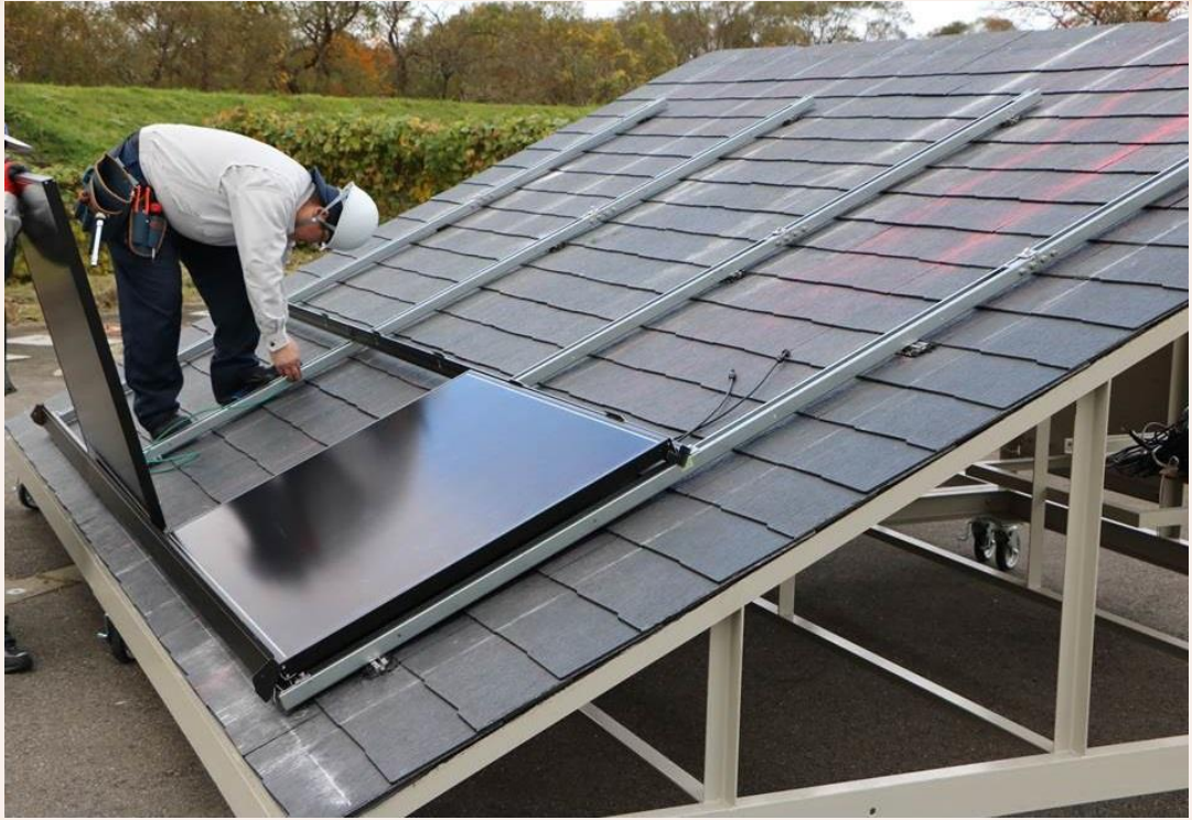
・太陽光パネルの取り付け
