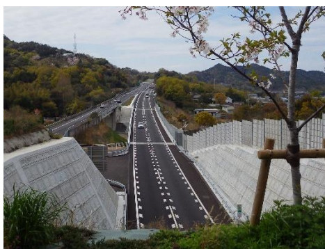
株式会社愛亀のメンテナンスによる高速道路
