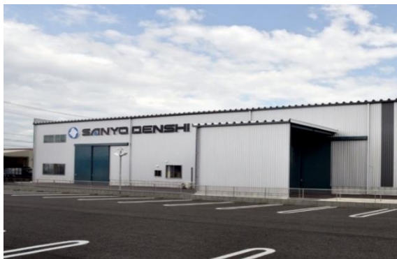
三洋電子株式会社の工場外観
