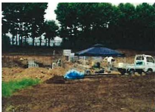
写真 7 : 現場に設置したテント
