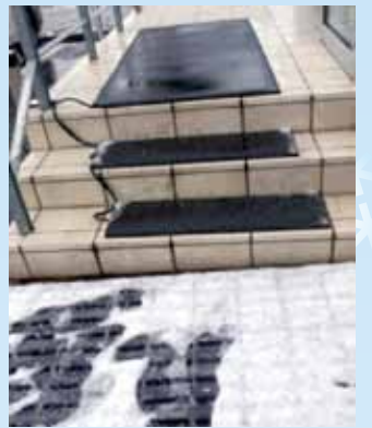
《ヒートマットの設置例》
