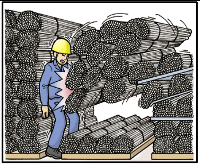
鉄筋束崩壊
