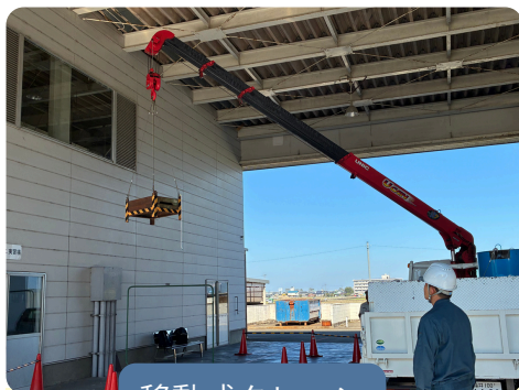
移動式クレーン
