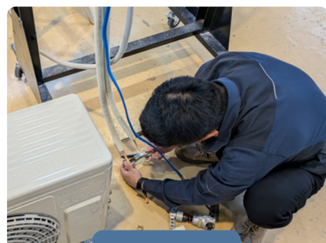
エアコン施工
