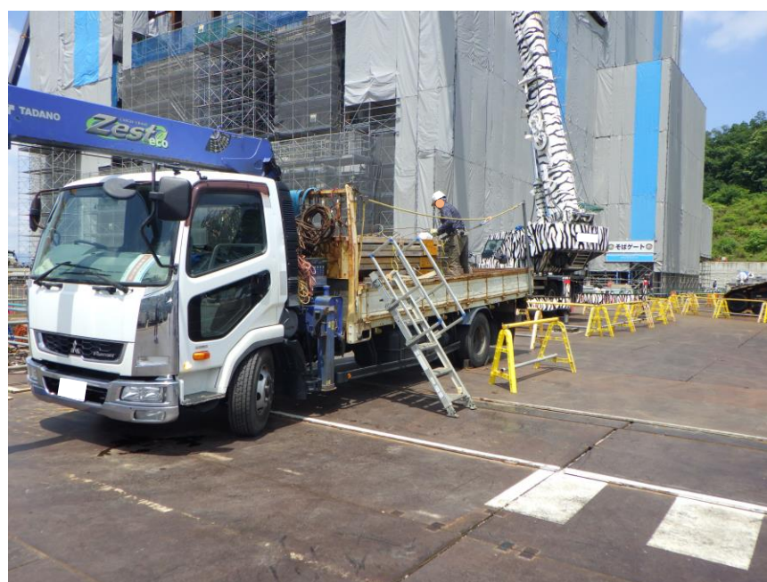
荷役作業時の昇降設備 及び墜落転落防止対策
