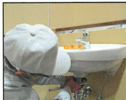
給排水設備の訓練内容の説明
