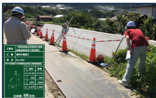
←「電子小黒板ソフト」使用状況 (作業員が現場で実際に黒板を持つことなく、同様の撮影ができる)
