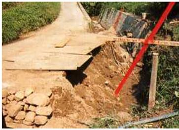
鉄板敷をしているが土砂が崩れており路肩崩壊防止が不十分な例
