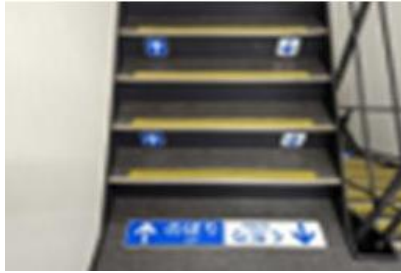
階段に滑り止め防止マットを設置する
