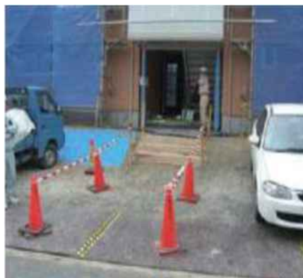
トラテープで鉄板の段差解消
