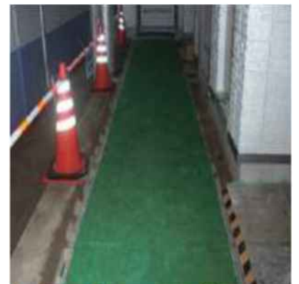
滑り止めマットの敷設
