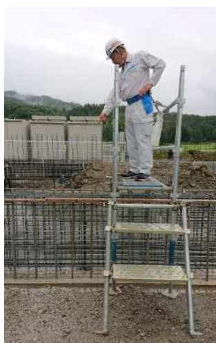
建設現場の通路及び昇降設備を確認する委員
