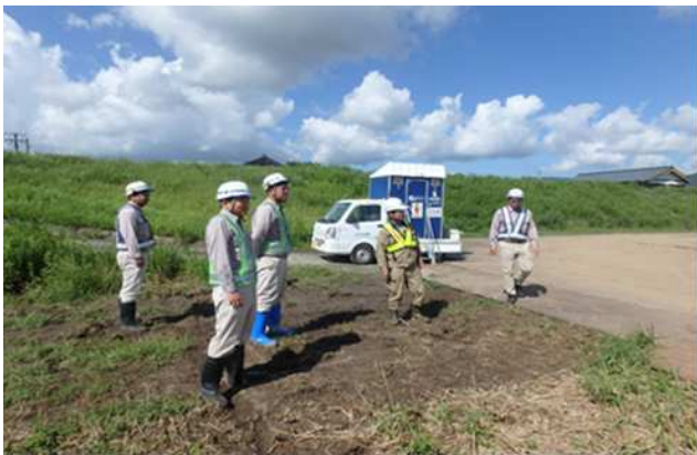
建設業労働災害防止協会福井県支部及び各分会のパトロール実施状況
