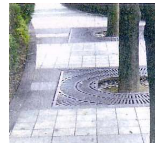
植込みの段差
