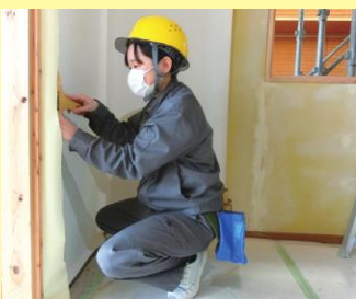
▲内装工事(壁紙貼り)
