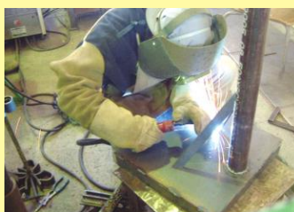
▲作業台の製作
