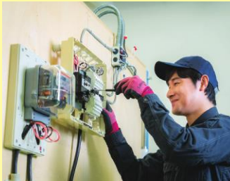
▲配管・配線工事
