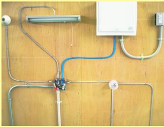
▲ケーブル配線工事
