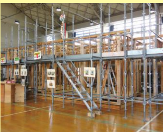
▲木造住宅の新築工事
