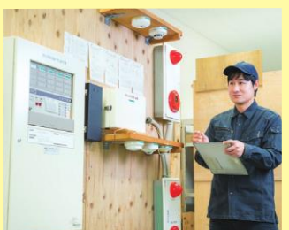
▲消防設備工事・点検
