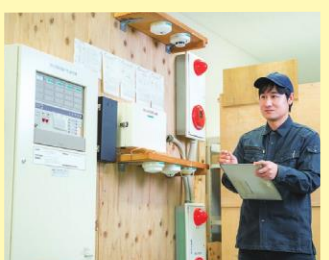
▲消防設備工事・点検
