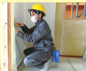
▲内装工事(壁紙貼り)
