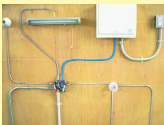
▲ケーブル配線工事
