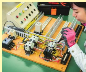
▲制御盤配線・点検
