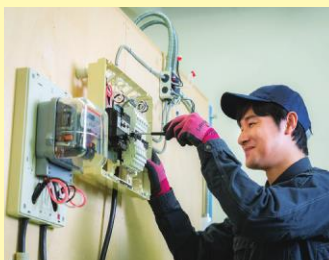
▲配管・配線工事
