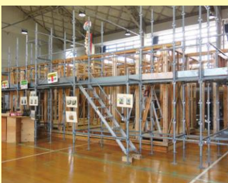
▲木造住宅の新築工事
