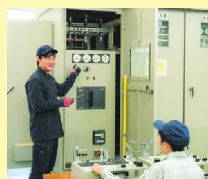
▲受変電設備点検
